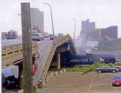
■ Kolaps mostu I-35W přes Mississippi
